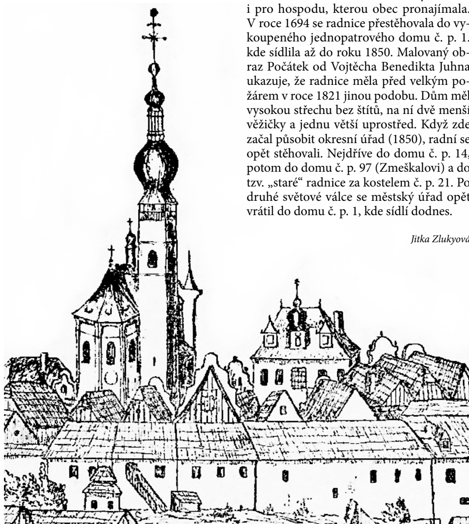
radnice č. p. 1 před požárem
